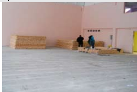
НА ФОТО: РЕМОНТНЫЕ РАБОТЫ СПОРТЗАЛА 8 ОБЩЕЖИТИЯ
